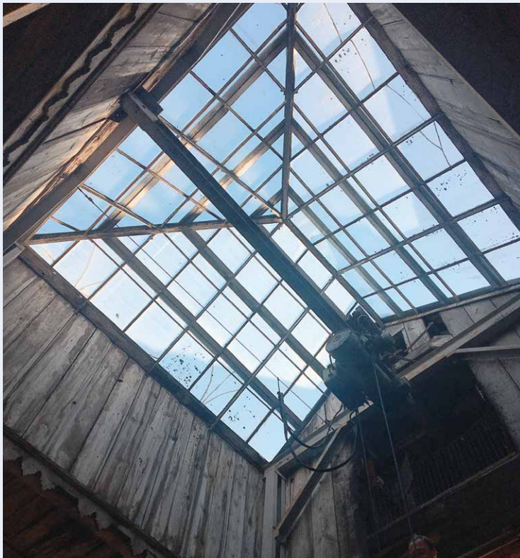
Das Dach eines alten Speichers in Salzwedel
